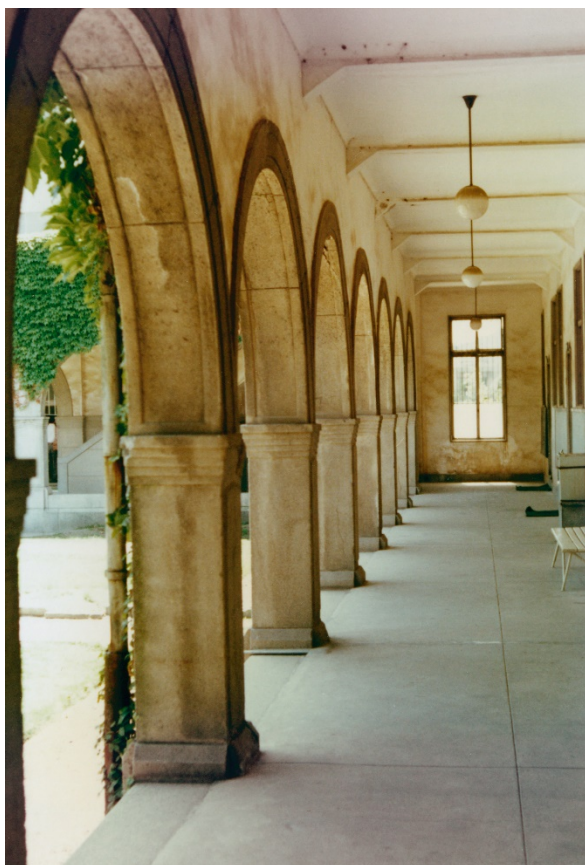
解体前の旧兼松記念館
