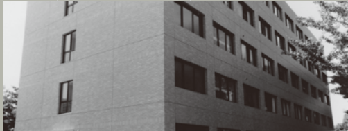
竣工当時の第4学舎
